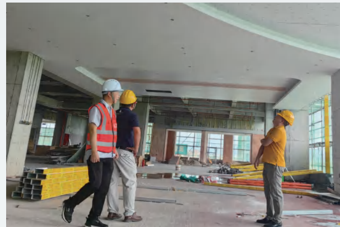
检查办公楼办公区吊顶精装样板
