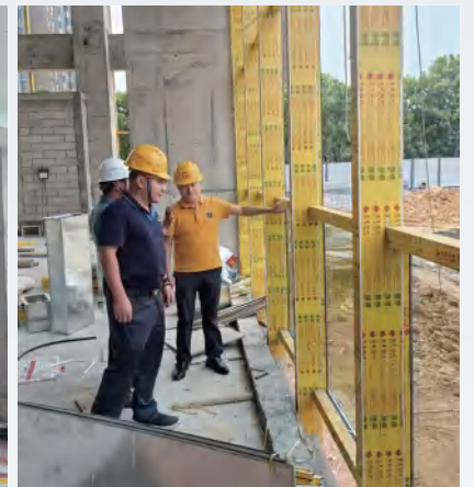
检查施工质量
